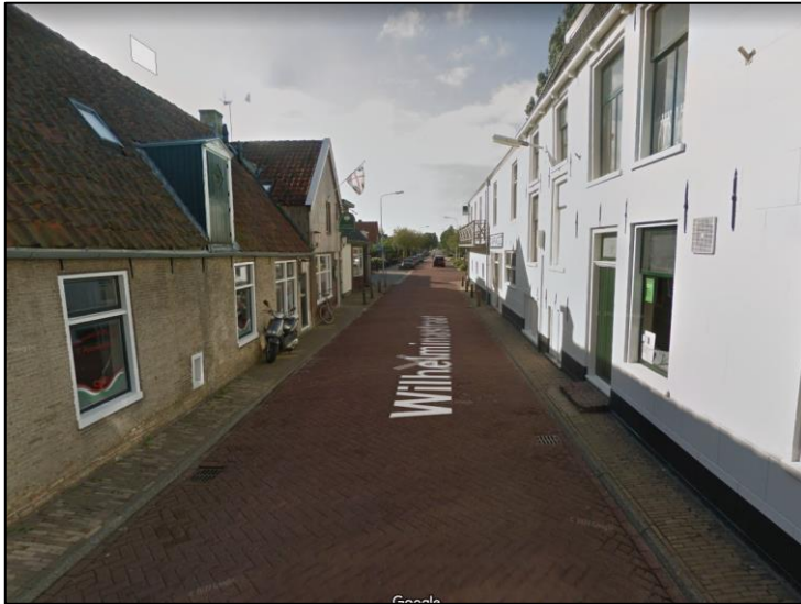
Afbeelding 6.1 Wilhelminastraat in Balk. Hier is geen ruimte voor maatregelen aan het maaiveld (Google Street View)
